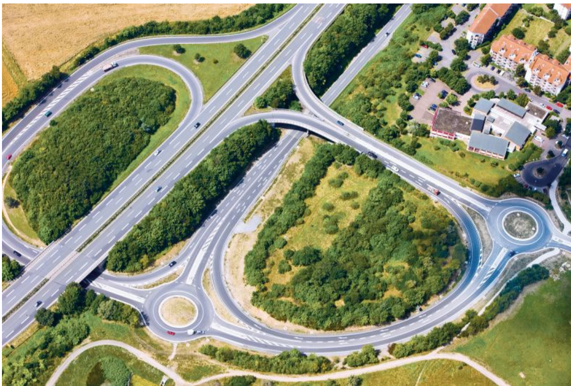
Projekt: Gießen-Kleinsinden B49 Kreisverkehr (© Ingenieurbüro Ohlsen GmbH)
