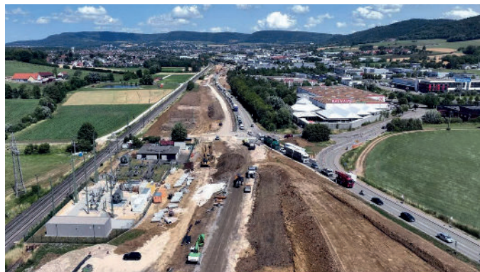
Bauphase (© Regierungspräsidium Stuttgart, Referat 47.2)
